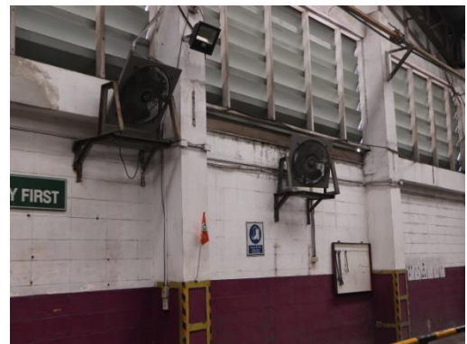
รูปที่ 2.1-27 พัฒนาระบายอากาศในอาคารผลิต
