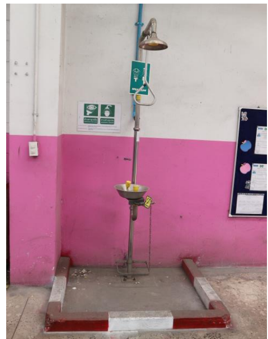
รูปที่ 2.1-31 ที่ชำระล้างสารเคมีอันตราย ที่ล้างมือและล้างหน้า
