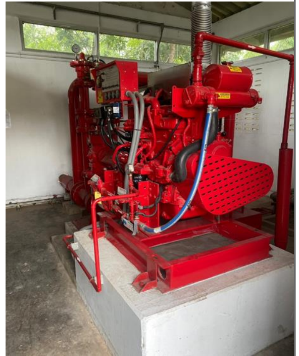
รูปที่ 2.1-37 ระบบเครื่องสูบน้ำดับเพลิง ระบบ Vertical pump
