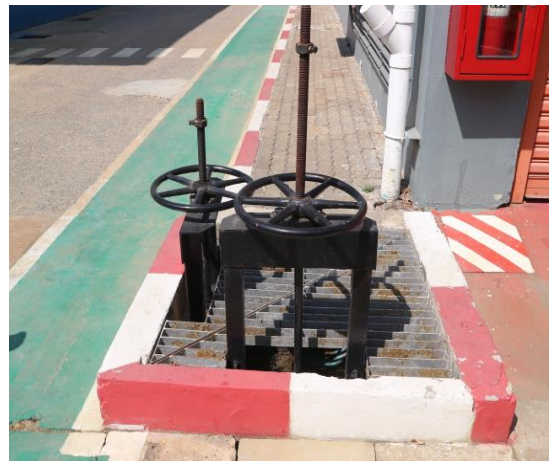
รูปที่ 2.1-18 รูปท่อรวบรวมน้ำฝนปนเปื้อน ก่อนเข้าระบบบำบัดน้ำเสีย
