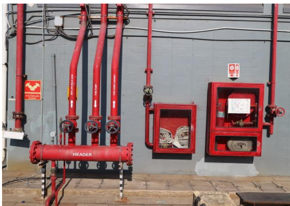
รูปที่ 2.1-36 ระบบดับเพลิงแบบสายสูบล
