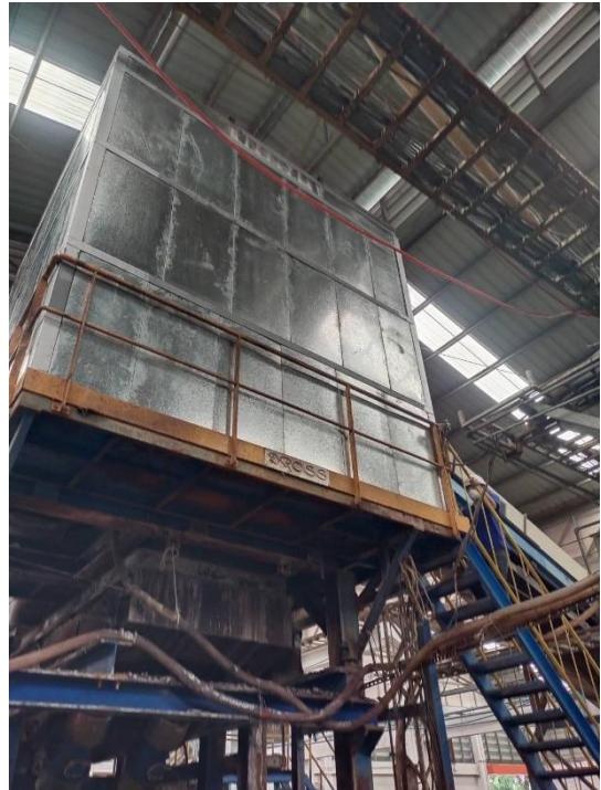
รูปที่ 2.1-9 ห้องเก็บ Battery Breaker เพื่อลดเสียงจาก แหล่งกำเนิด
